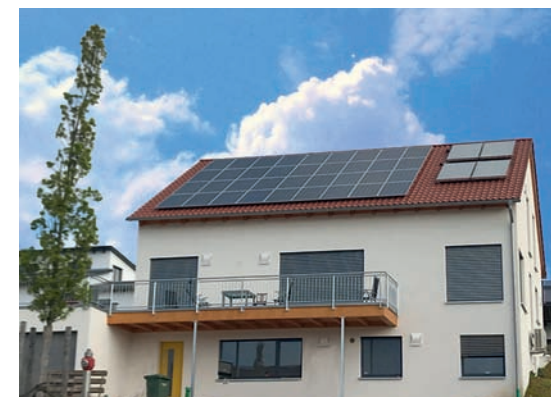
Einfamilienhaus in Wenzelnbach, KfW-Effizienzhaus 40
